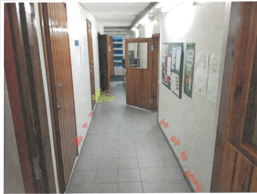
Käytävä. Lattian lukemat 69-81= normaalia
