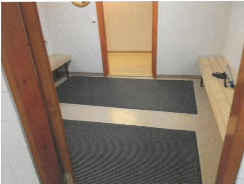
Tytöt Pukuhuoneen lattian lukemat Gann 79-97=kostea
